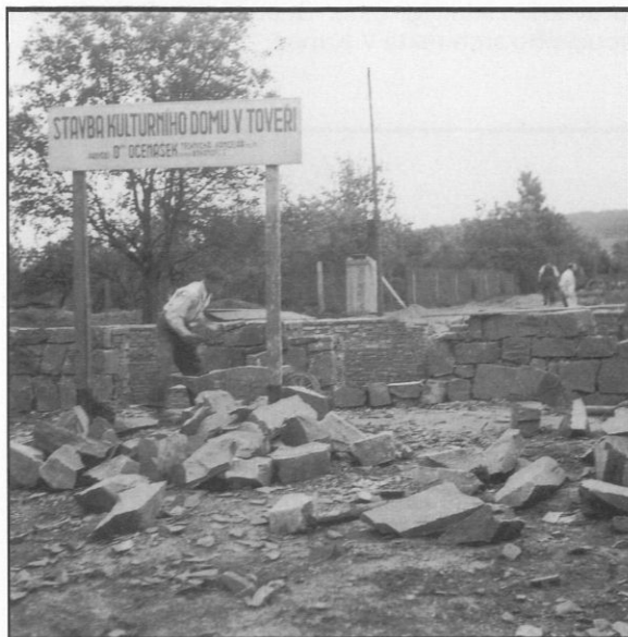
Zahájení stavebních prací firmou Očenášek. Foto Josef Vajda, 1948.
