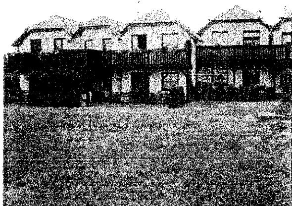
Oprava bytu Oprava střech
